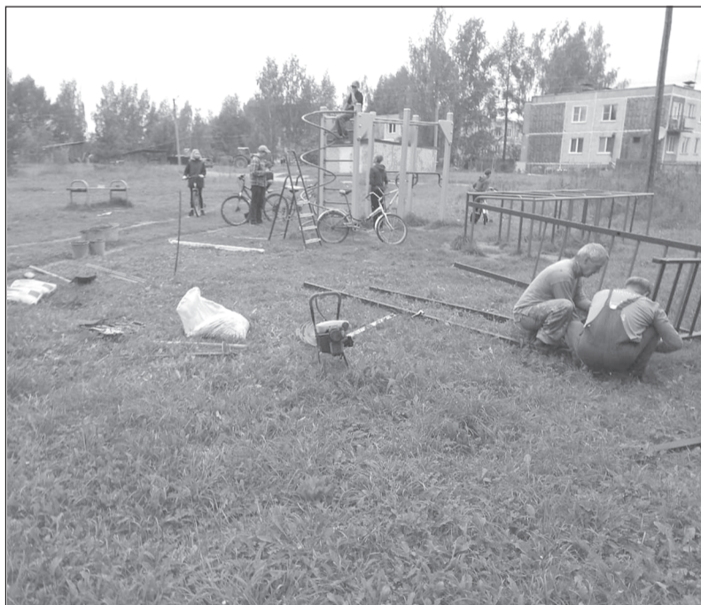
Заканчивается монтаж оборудования
